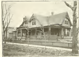
Residence of A. H. Doune
