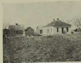
RESIDENCE OF S. A. NORRIS, R. F. D. No. 3, ALTON, KANSAS.
