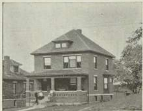
RESIDENCE OF GEO. H. ROBINSON, MOBERLY, MO.
