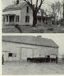
RESIDENCE AND BARN OF S. O. LINTON, AYALON, MO.
